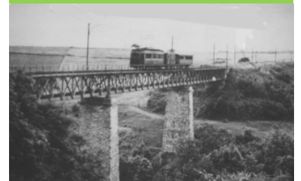
SOUCIEU - Pont sur le Furon
