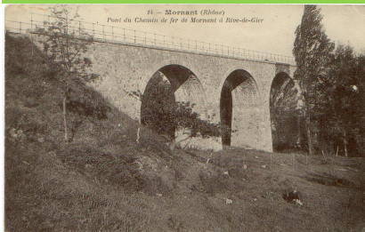
Mornant - Le pont de la Pavière
